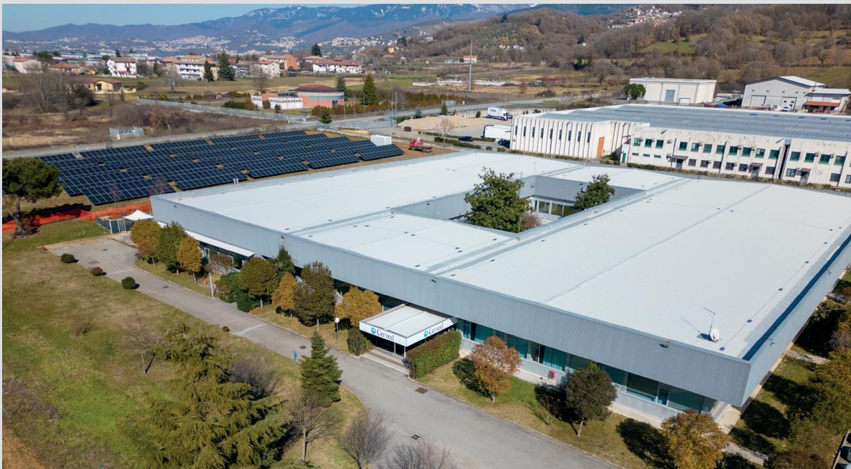
Installato sul terreno di proprietà della sede di Mangone, l'impianto è composto da **720 moduli fotovoltaici** in silicio monocristallino, supportato da 3 inverter trifase da 100 kW ciascuno.
